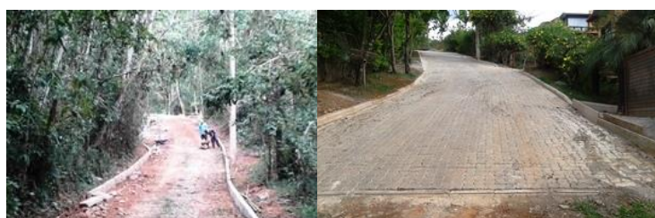
Instalação de meiofio na Alameda Felicidade e colocação do piso na Flores
